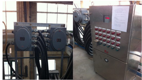
图10 3141 新增现场控制柜以及中间接线箱把点引入控制室
