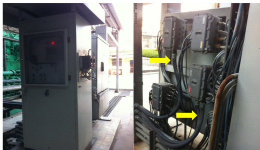
图8 3131 利旧现场控制柜以及中间接线箱把点引入控制室
