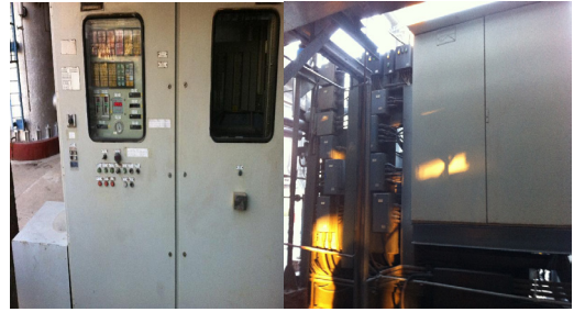
图9 3151 利旧现场控制柜以及中间接线箱把点引入控制室
