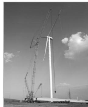
图1 1250吨履带起重机吊装
