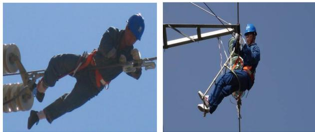
a. 横卧导线更换防震锤      b. 使用软梯头更换防震锤
