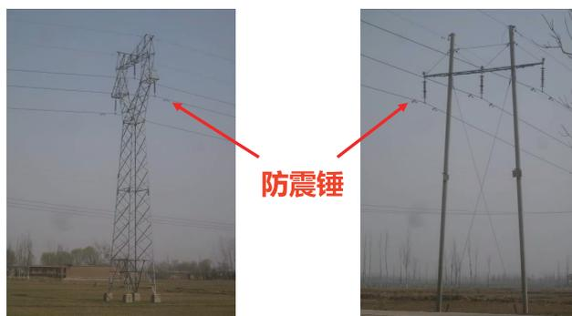
图 1 架空输电线路防震锤安装位置
