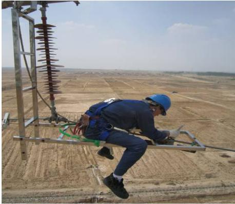
图5 旋转折叠硬梯现场使用效果
