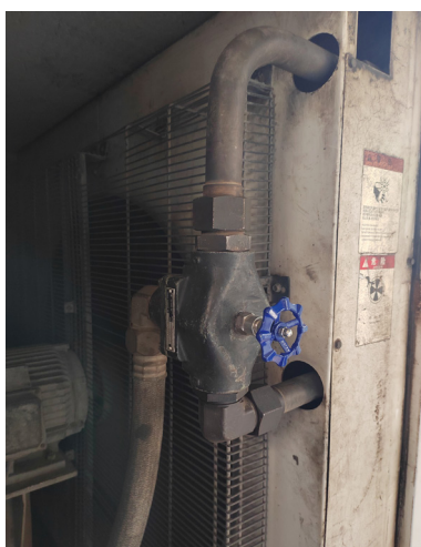
图1 现场安装情况
