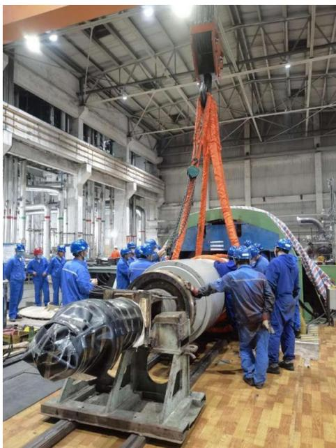
图2 发电机穿转子
