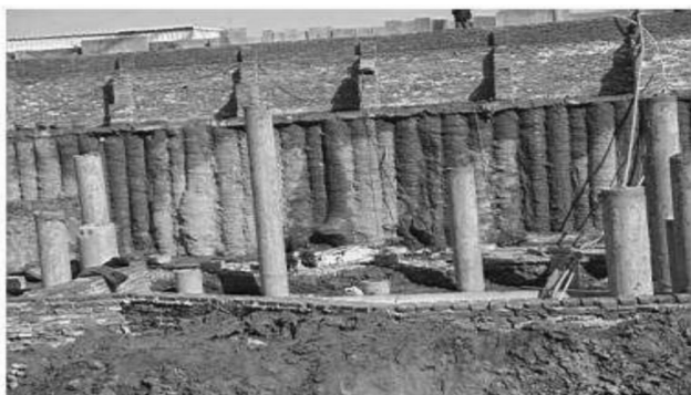
图1 护坡桩施工
