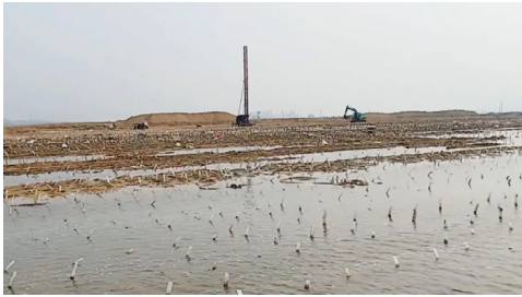
图2 真空堆载联合预压法施工
