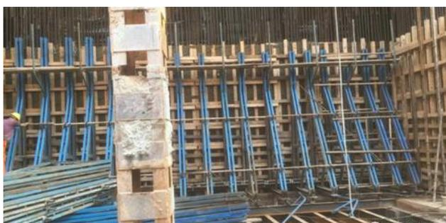
图2 地铁车站模板支架施工现场效果图
