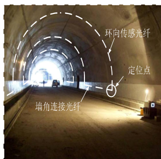
(a) 分布式光纤应用于隧道工程监测
