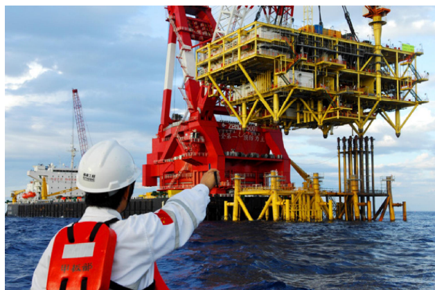
图1 海洋平台机械设备安装
