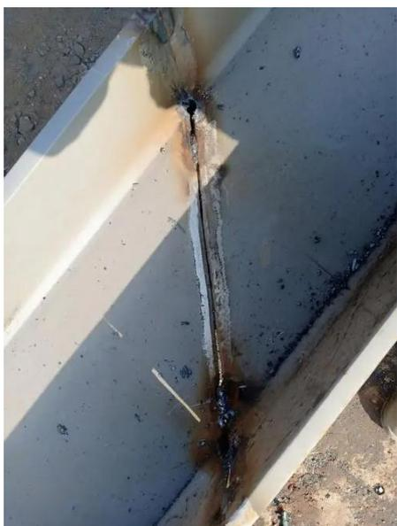
图1 钢结构桥梁裂纹
