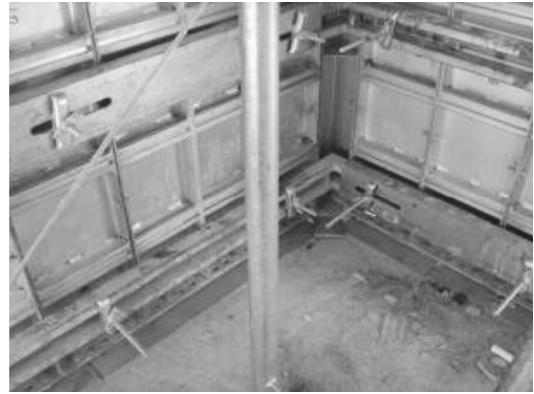
图1 铝合金模板转角组装
