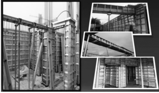
图2 梁模板安装
