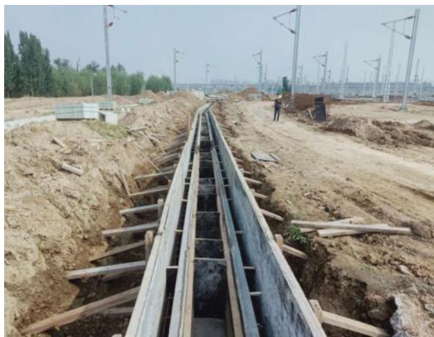
图1 路基排水施工
