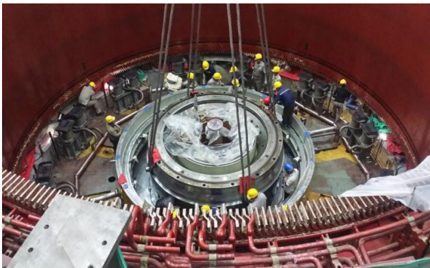
图2 水电站检修现场
