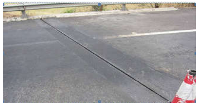
图5 伸缩缝完工修复完工后最终状态
