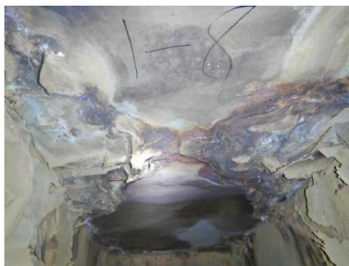
图2 某压载舱结构板材腐蚀情况
