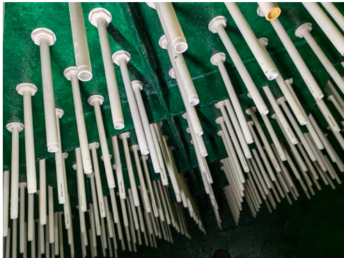
图7 曝气滤池内更换过滤组件
