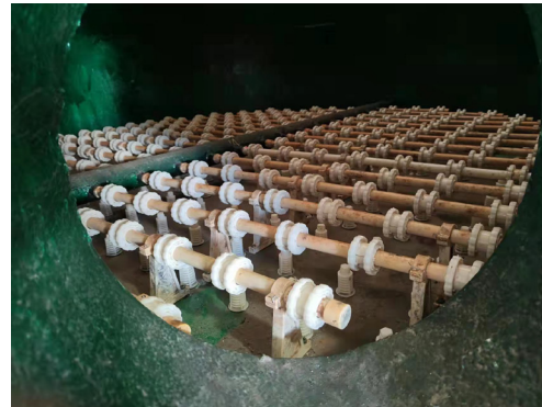
图8 曝气滤池内更换曝气组件
