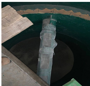
图2 滤池反洗出水管口加装滤网
