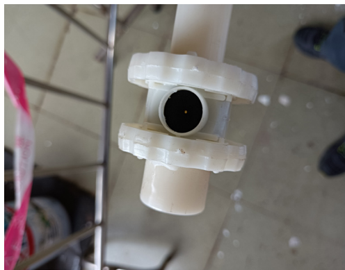
图1 曝气孔孔径调整为1.5mm
