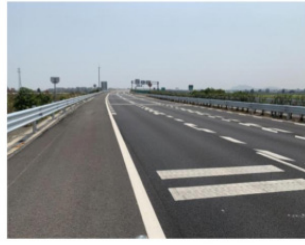
图 2 AK1+580 段已换填泡沫轻质土
