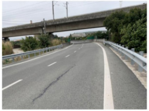
图 4 D 匝道存在纵向裂缝
