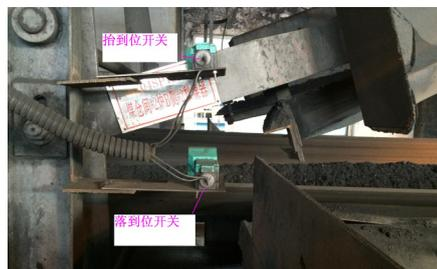
图1 犁煤器位置信号改造后安装图
