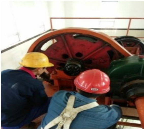
图2 机械设备检查维修现场
