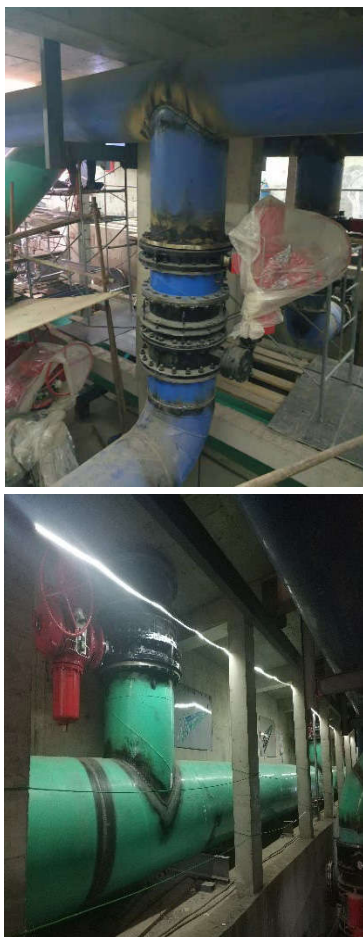
图4 拼装焊接
