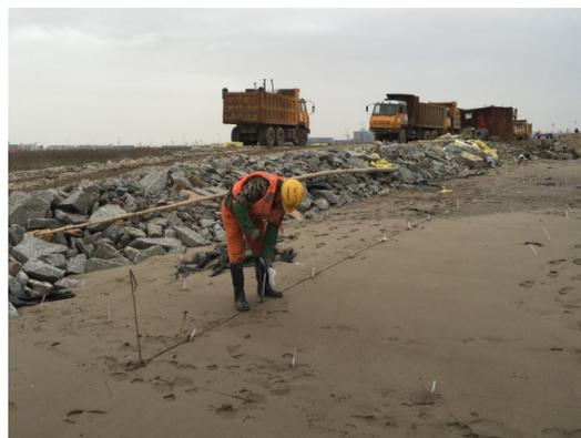
图 9 插板机施工板位放样
