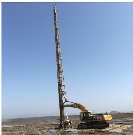
图4 履带液压式插板机
