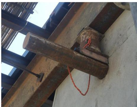
图4 钢棒与砂桶连接装置
