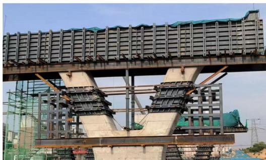
图3 盖梁支撑体系施工效果
