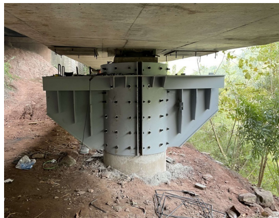
图 5 圆柱顶增设钢盖梁
