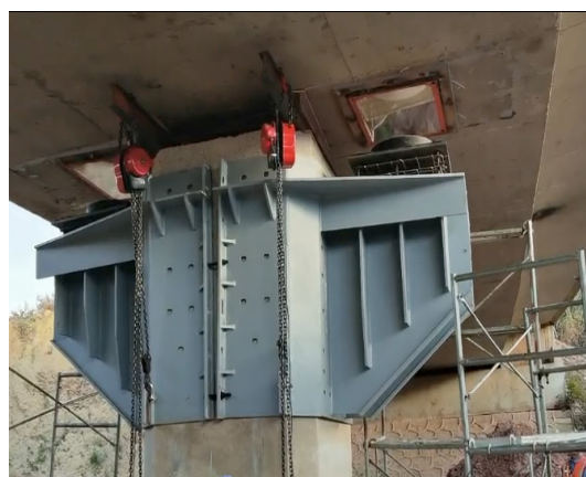
图 6 方柱顶增设钢盖梁
