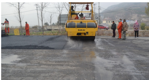
图2 沥青路面横向接缝施工
