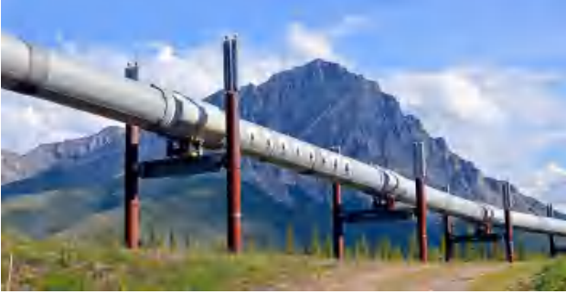
图1 跨阿拉斯加输油管道系统(TAPS)
