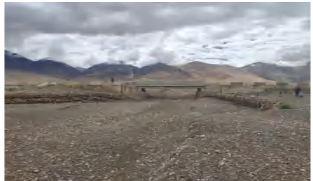
图5 严重压缩河床断面的桥
