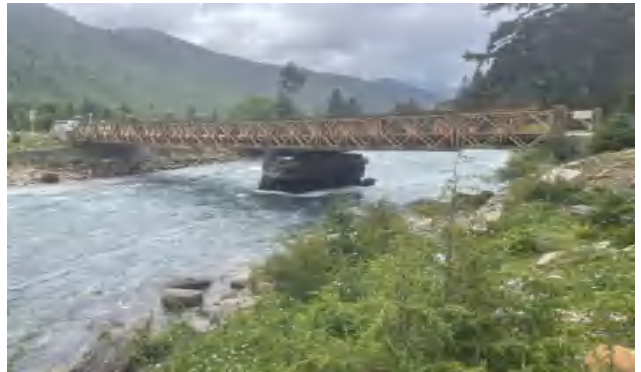
图4 既有钢贝雷梁桥
