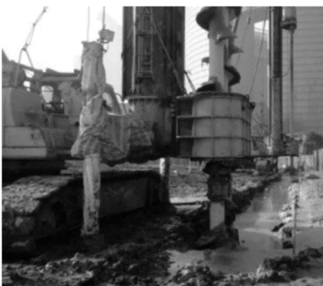
图2 水泥搅拌桩施工
