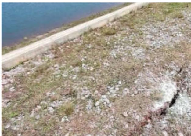
图1 某小型水域坝体裂缝现场情况
