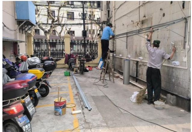
图2 老旧社区线路整治施工现场
