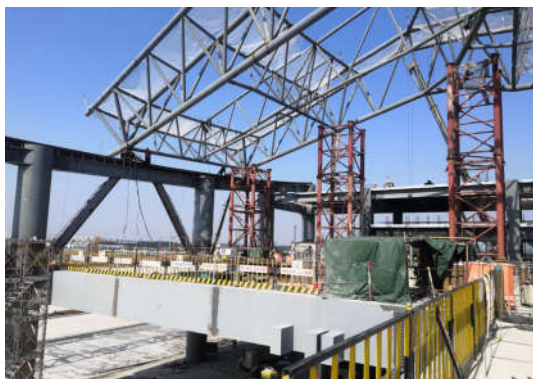
(a) 现场滑移调试
