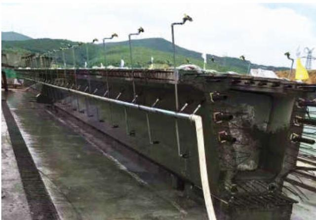
图1 重载货运铁路混凝土梁体结构自动喷淋养护示意图
