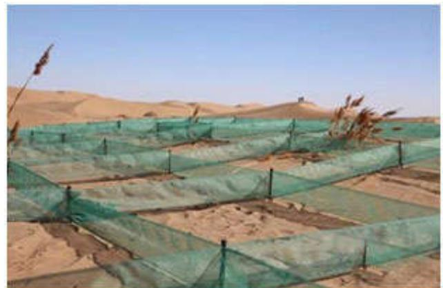
图1 网格沙障固沙
