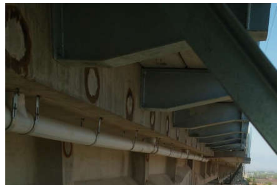
图 10 跨既有线路声屏障钢托架设计图
