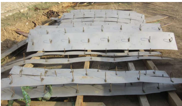
图 6 不锈钢湿接缝底模实物图
