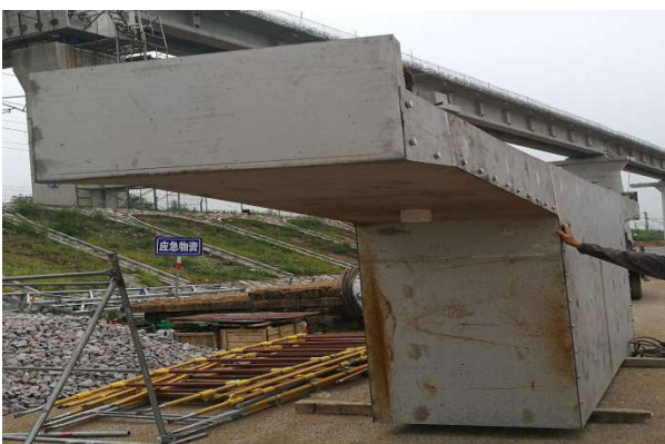
图 3 调跨梁不锈钢模板拼装整体
