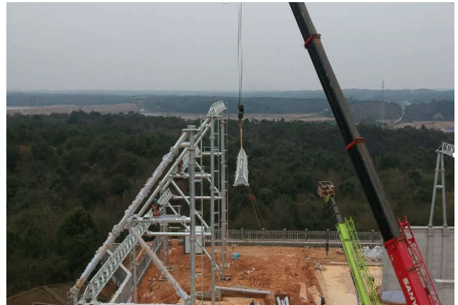
图 11 220kV 风帆构架吊装现场
