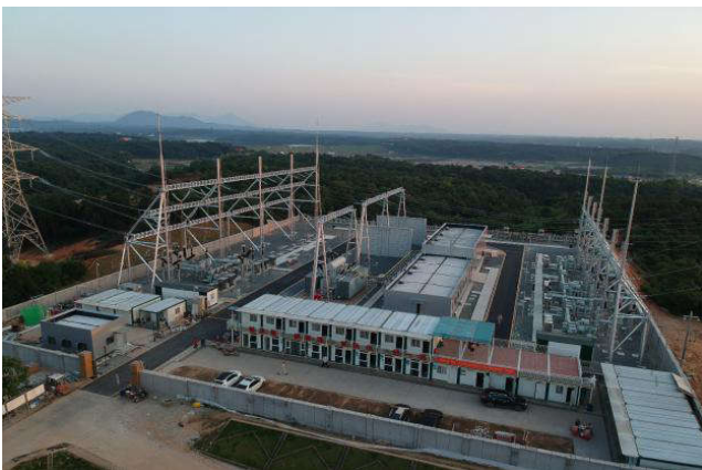
图 10 该站建设过程中的实照
