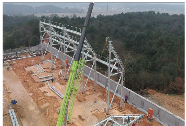
图 12 110kV 风帆构架吊装现场
