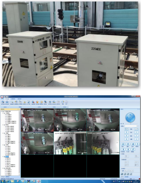
图 1 可视化接地安装效果及其管理系统
