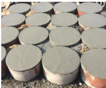
图 8 钢管支墩浇筑砼
