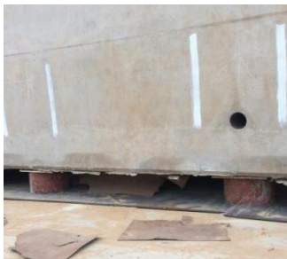
图 9 钢管支墩支撑
