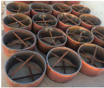
图 7 钢管支墩制作
