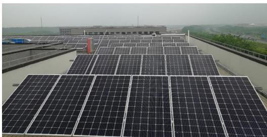
图 4 屋顶光伏电路板
