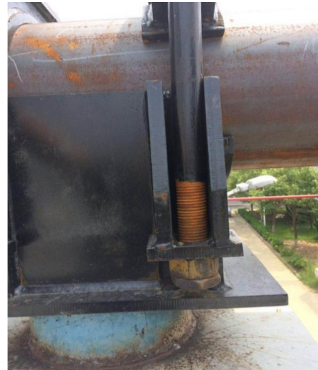
图 2 冷拉后固定架完好
