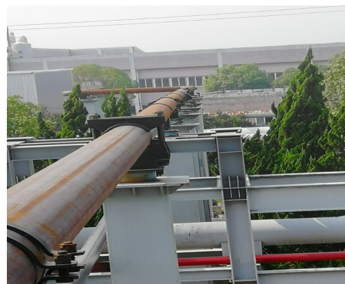
图 4 9#~16# 支架冷拉后整体情况
