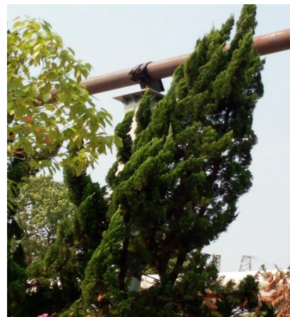
图 3 冷拉后 14# 导向支架旋转脱空
