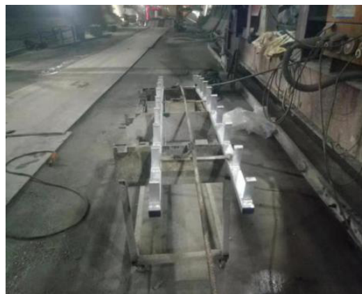
图 3 槽道焊接及接地钢筋焊接
