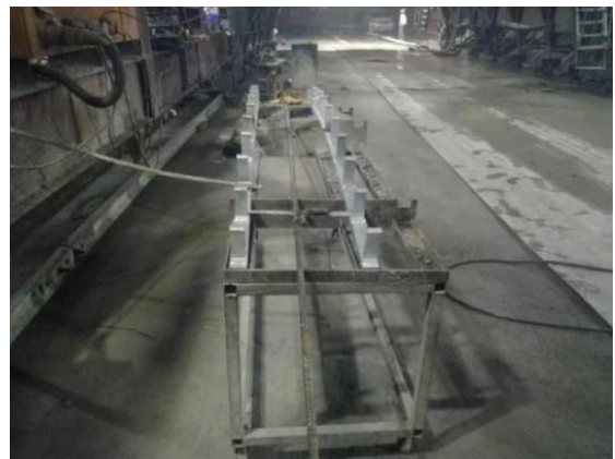
图5 槽道接地“L”型钢筋焊接图
