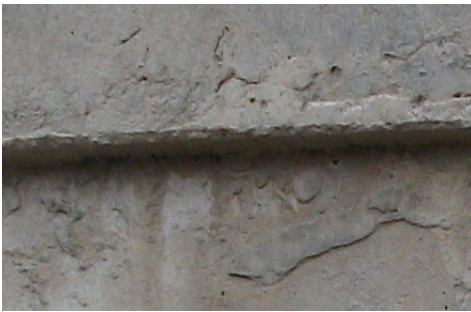
图 2 混凝土涨模、错台示意图
