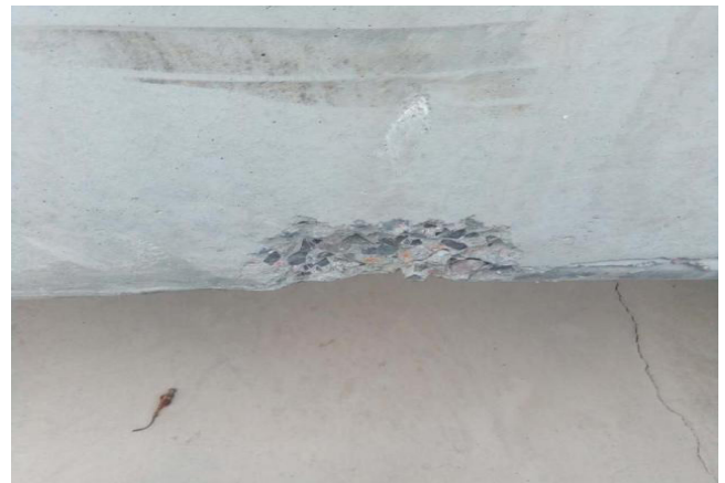
图8 缺棱掉角示意图
