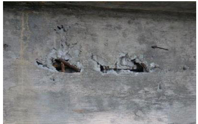
图7 表面孔洞示意图
