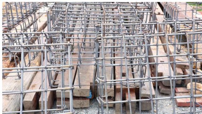
图2 钢筋安装
