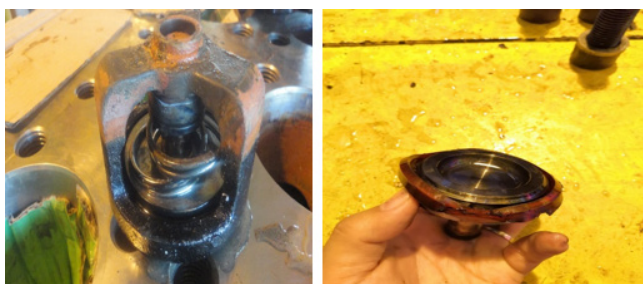
图2 柱塞泵故障现象
