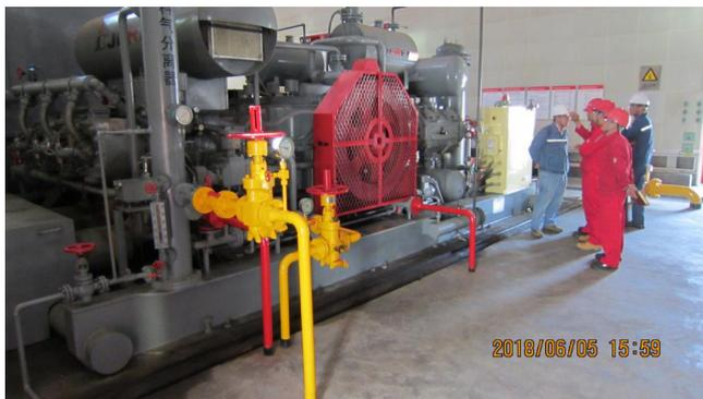
图 1 DPC-2803 型整体式往复压缩机
