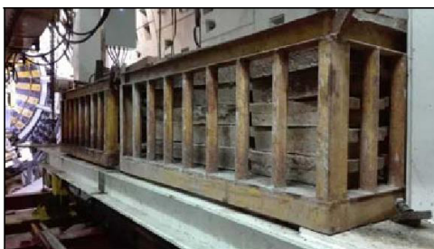
图 14 通道内压重抗浮示意图
