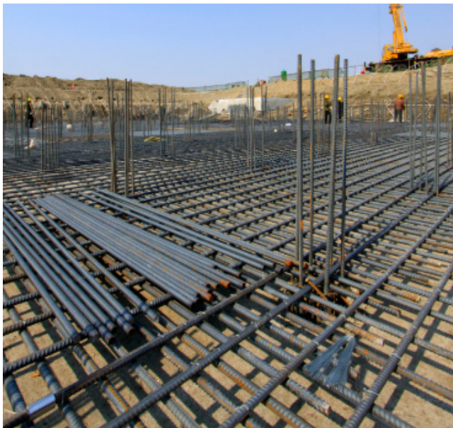
图1 某房屋建筑工程钢筋施工现场图
