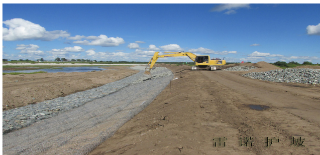
图2 石料填充施工图
