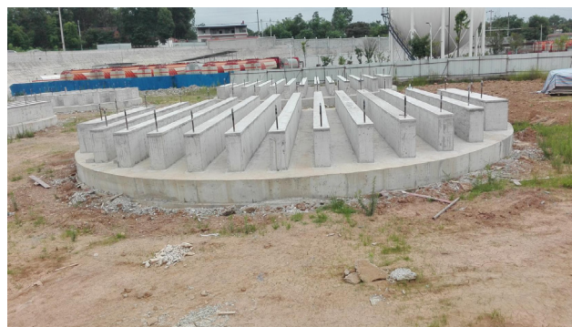
图 9 预埋螺栓完成现场图
