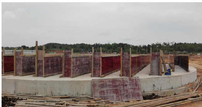
图3 完成剪力墙钢筋笼、模板调正校平
