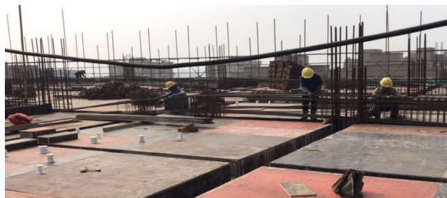
图 12 综合楼 13 层顶板实时过程对比 (a)
