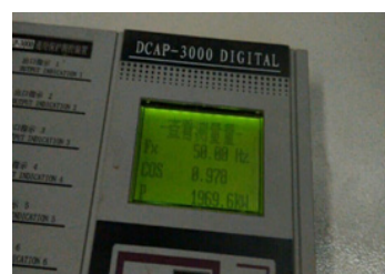
图 3 给 SVG 馈电柜微机保护屏
